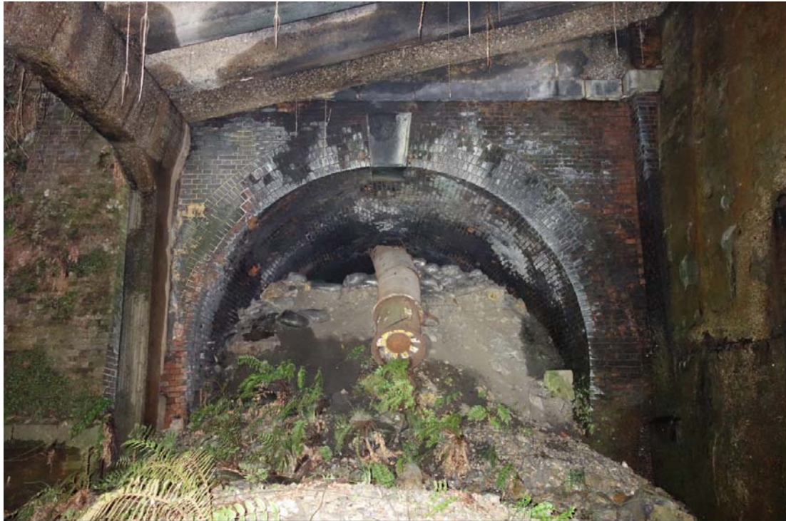
◆第 7 号トンネル入り口（古虎溪駅側）の写真です。
